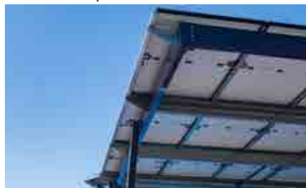
Toiture photovoltaïque en porte-à-faux
